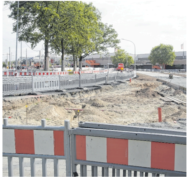
Erneut sind Bauarbeiten am Roland-Center geplant – dann fährt keine Straßenbahn.
