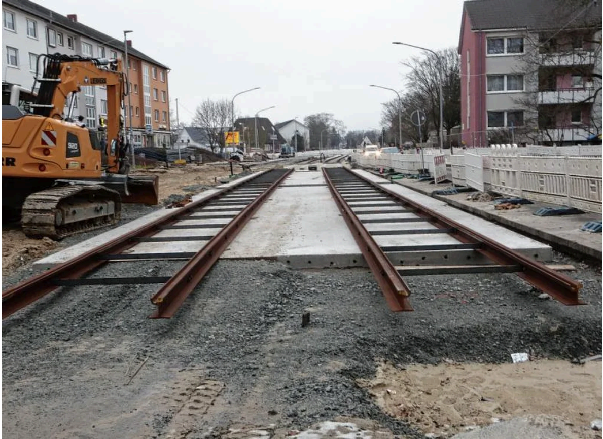
Gleisbau in der Heinrich-Plett-Allee: Die Straße wird für die Straßenbahnlinie 1 erweitert.
